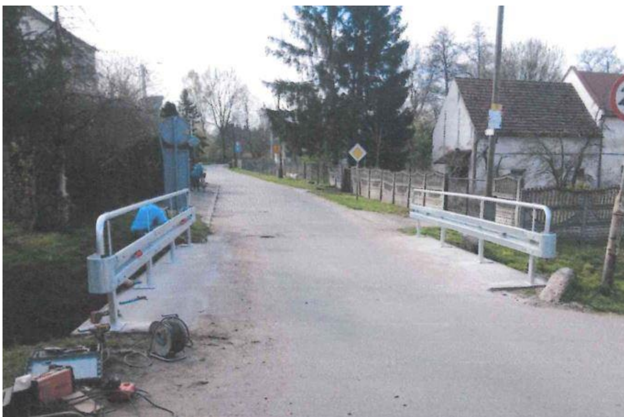
W ramach działań zabezpieczających przed kolejnymi powodziąmi odbudowano murek oporowy w celu zabezpieczenia działek w Ziębicach, przy ul. Wałowej przy Miejsko Gminnym
