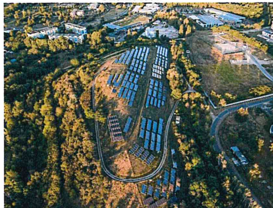
Rysunek 4 Instalacje fotowoltaiczne na dawnym składowisku odpadów we Frankfurcie nad Odrą w Niemczech
